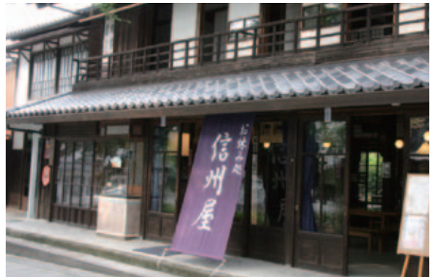
明治・大正・昭和と続いた商家を改修した無料休憩所。流れる空気がどこか丸みを帯び、落ち着く空間だ
