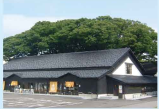
酒田夢の倶楽(C-3) 全国有数の米どころ庄内のシンボルでも現役の農業倉庫として活躍している山居倉庫の2棟を改良し、観光施設としてオープンした。 TEL 0234-22-1223
