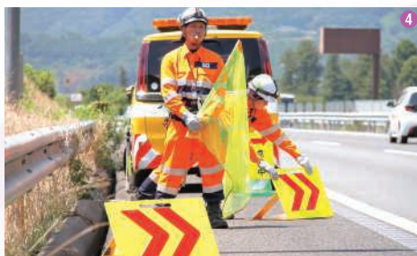
①トンネル内装板の点検作業の様子 ②トンネル内では手すりの変状なども確認 ③点検終了後は、その日の点検数量の入力や点検で発見した変状データを登録 ④本線路肩内で行う日常点検では路肩簡易規制も自分たちで実施
