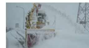
ロータリー除雪車による除雪作業
