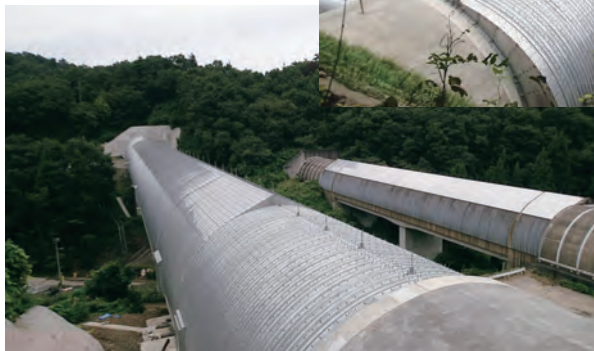
スノーシェルター(雪森橋)
