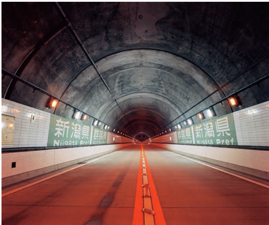
ここが関越トンネルの県境付近。 電力供給のサービスエリアがここで分かれますが、関越トンネル内は両方の電気を使用しています
