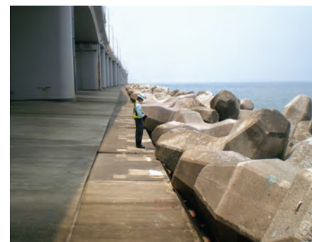
消波ブロック設置状況
