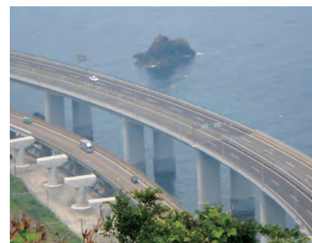
海上に建設された高架橋
