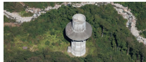
谷川立坑(群馬県側)
