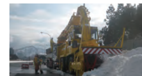
後方積み込み式ロータリー除雪車による排雪作業
