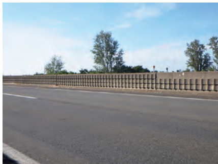
壁高欄の全体
