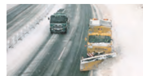
除雪トラックによる除雪作業
