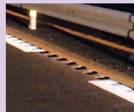
注意喚起溝 (中央部)
