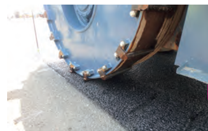
舗装工事の時、アスファルトが固まる前に、凹凸のついたタイヤで踏むことで溝をつくります。
