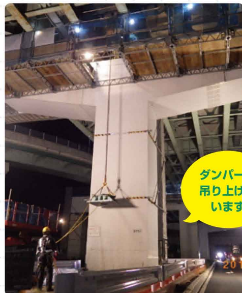
産業道路を交通規制した中での作業状況
