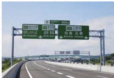
E45三陸道 利府JCT付近
