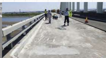
写真2 路面削り取り後の状況
