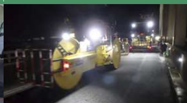
写真4 夜間の施工状況
