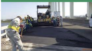
写真3 路面復元の施工状況
