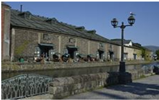
小樽運河 (小樽市)
