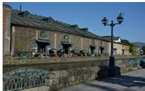
小樽運河(小樽市)
